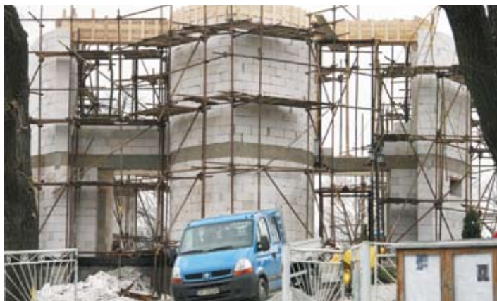
Slubne pokračuje aj výštvavba Domu smútku (pravda, aj vďaka teplej zime). Stavbári sú už v chórovej časti šľavby. Niektorí občania navrhujú, aby sme nový, dlho očakávaný objekt na cintoríne nazvali Domom nádeje.
