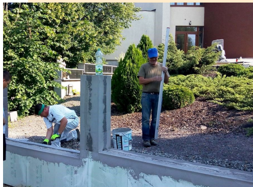
Práce na rekonštrukcii oplotenia cintorína
