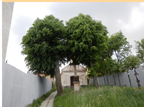
Kaplnka si vyžaduje rekonštrukciu
