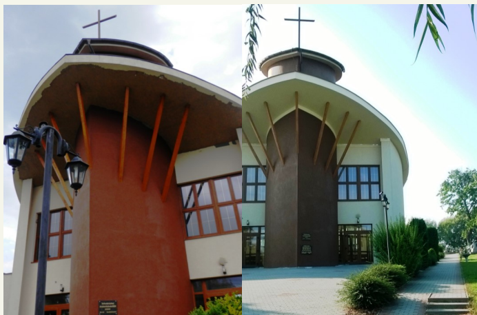
Oprava na Dome nádeje 2015
